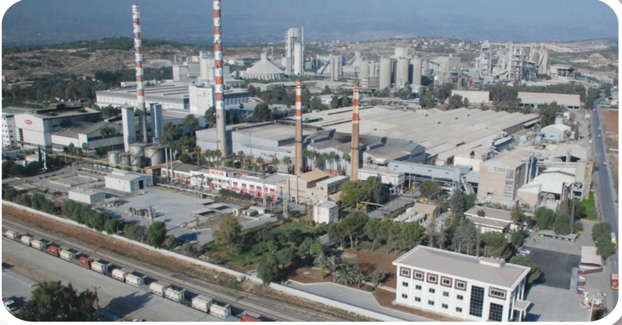
Paşabağçe Mersin Fabrikası absorpsiyonlu soğutma sistemi ve atık ısı kazanı sistemi kurulması. Mechanical installations of chiller systems and waste heat boiler systems in Paşabağçe Mersin Factory Buildings.
