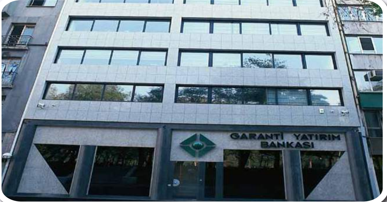
Garanti Yatırım Bankası Genel Müdürlük Binası tüm mekanik ve otomatik kontrol tesisatı. Mechanical installations and automatic control systems of Garanti Yatırım Bank Head Office Buildings.
