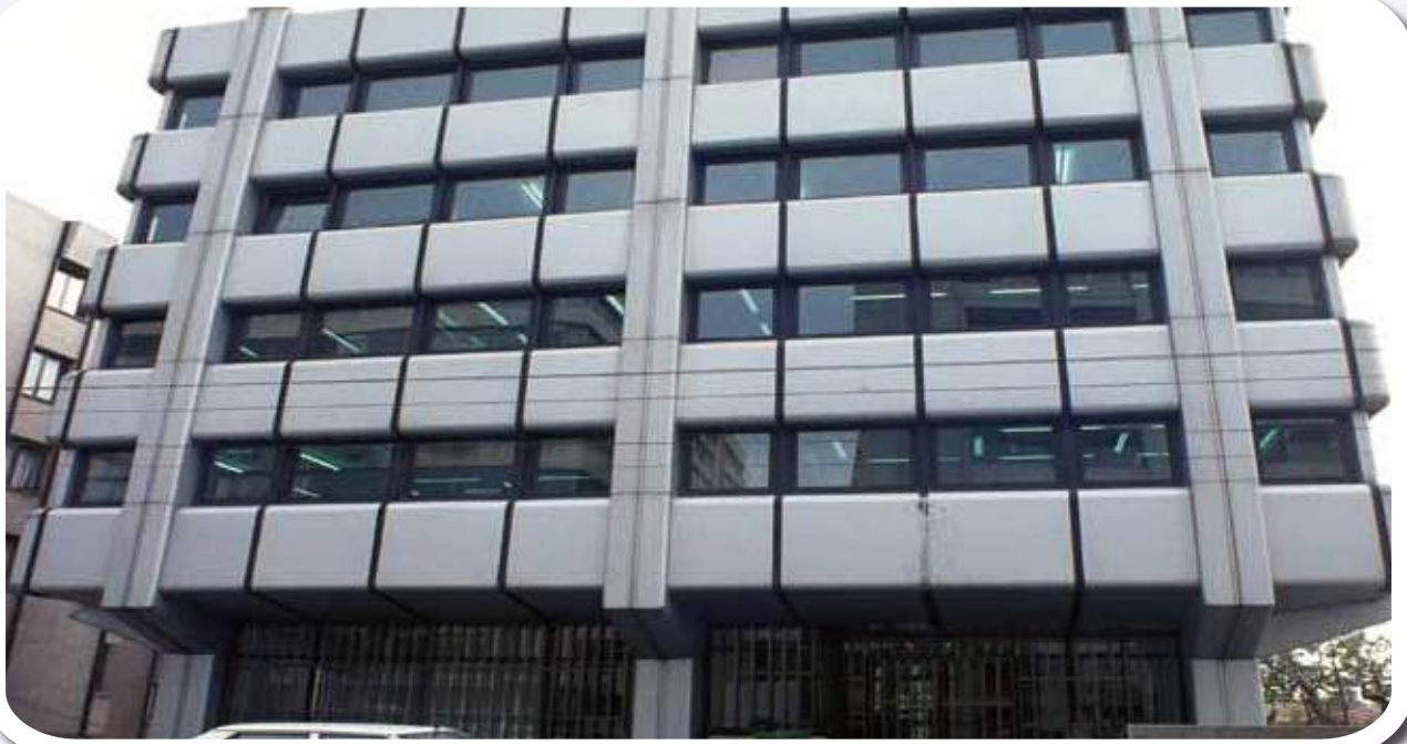
Garanti Leasing Genel Müdürlük Binası tüm mekanik ve otomatik kontrol tesisatı. Mechanical installations and automatic control systems of Garanti Leasing Head Office Buildings.
