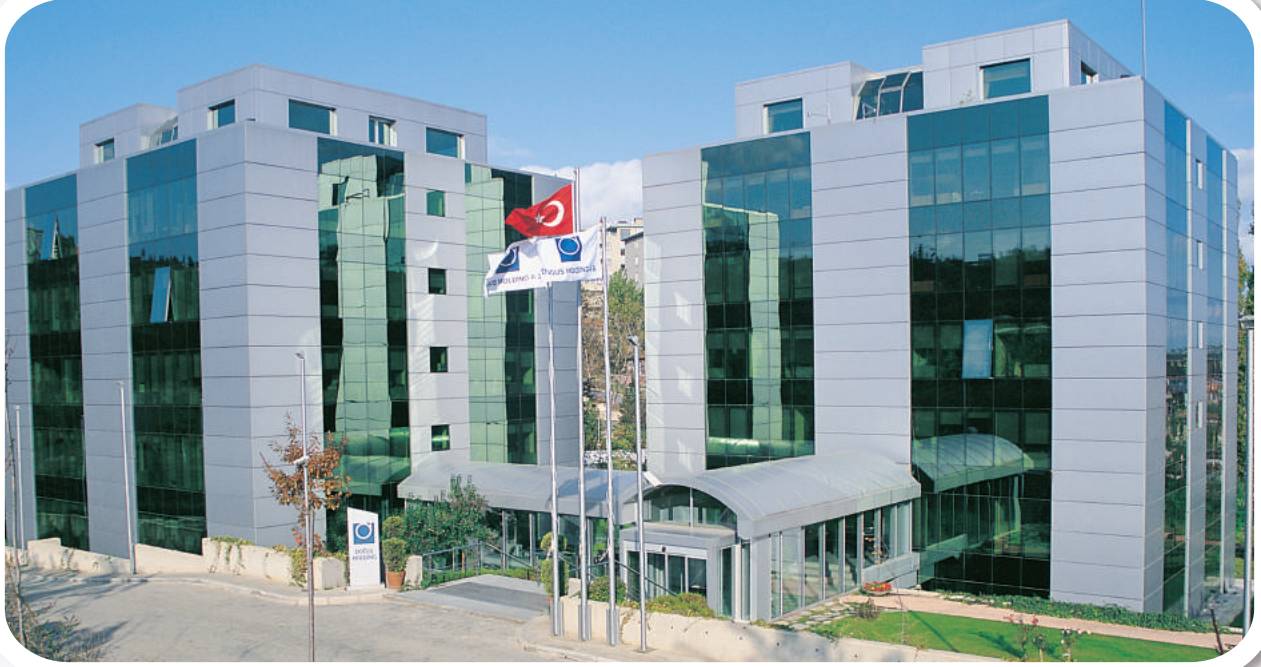
Doğuş Holding A.Ş. Genel Müdürlük Binaları tüm mekanik ve otomatik kontrol tesisatı. Mechanical installations and automatic controlsystems of Doğuş Holding A.Ş. Head Office Buildings.
