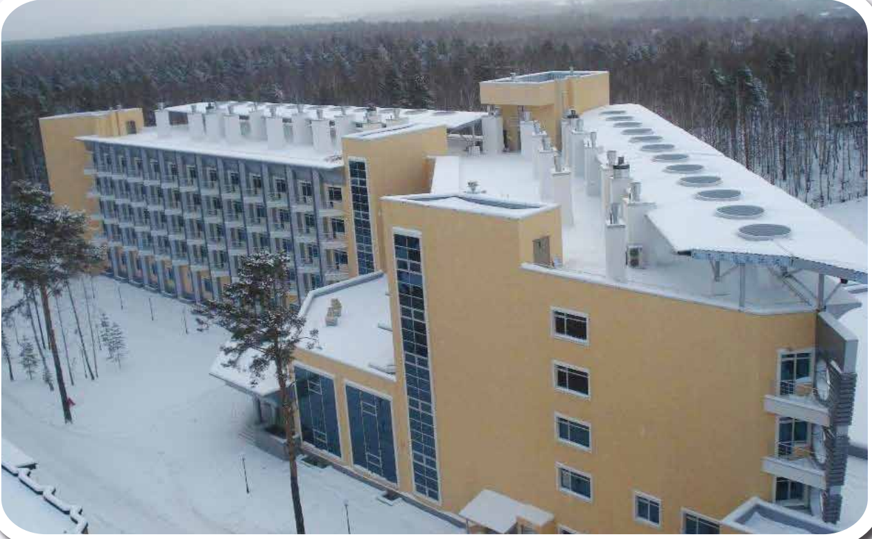
Rusya Tyumen Sibir Sanatoryum binası tüm mekanik tesisatı ve bina otomasyonu. Mechanical installations and building automation systems of Tyumen Siberia Sanatorium in Russia.
