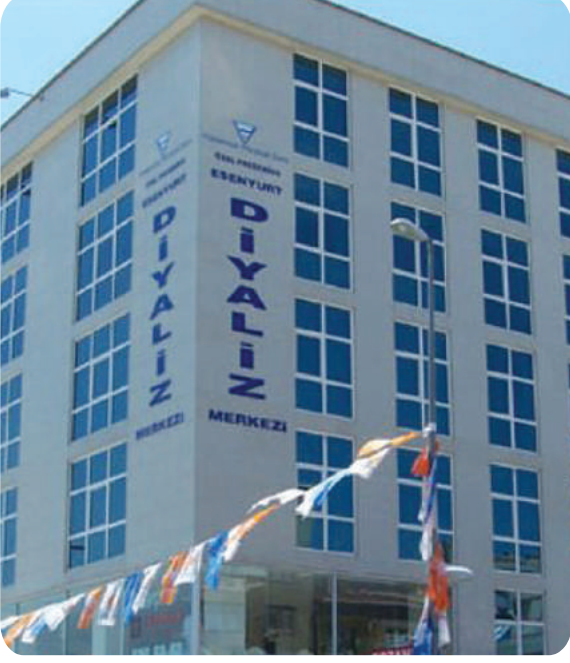
Esenyurt Diyaliz Merkezi tüm mekanik tesisatı. Mechanical installations of Esenyurt Dialysis Center.
