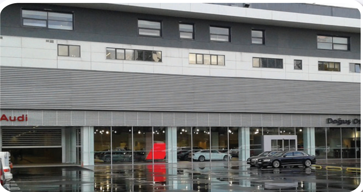
DoğuŖ Oto Power Center Audi, Skoda showroom servis ve idari blmlerinin elektromekanik tesisatları, Maslak / İst. Electro-mechanical installations of DoğuŖ Oto Power Center Audi, Skoda showroom services and office, Maslak / İst.
