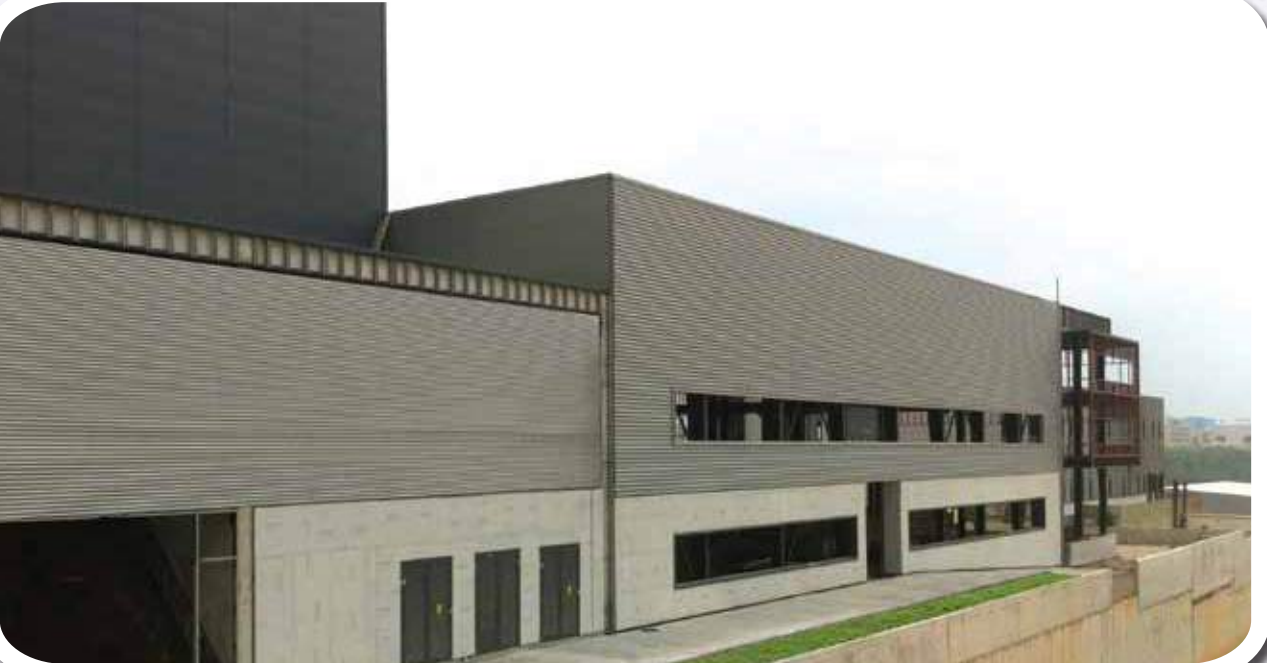
Orgachem fabrika binası tüm mekanik ve otomatik kontrol tesisatı. Mechanical installations and automatic control systems of Orgachem factory buildings.
