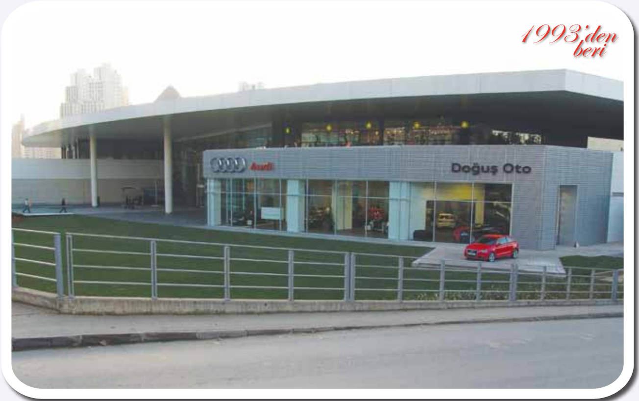
Doğuş Oto Kartal ve Maslak Showroom ve servis bölümleri mekanik ve otomatik kontrol tesisatı. Mechanical installations and automatic control systems of Doğuş Auto Kartal and Maslak Showrooms and Services.
