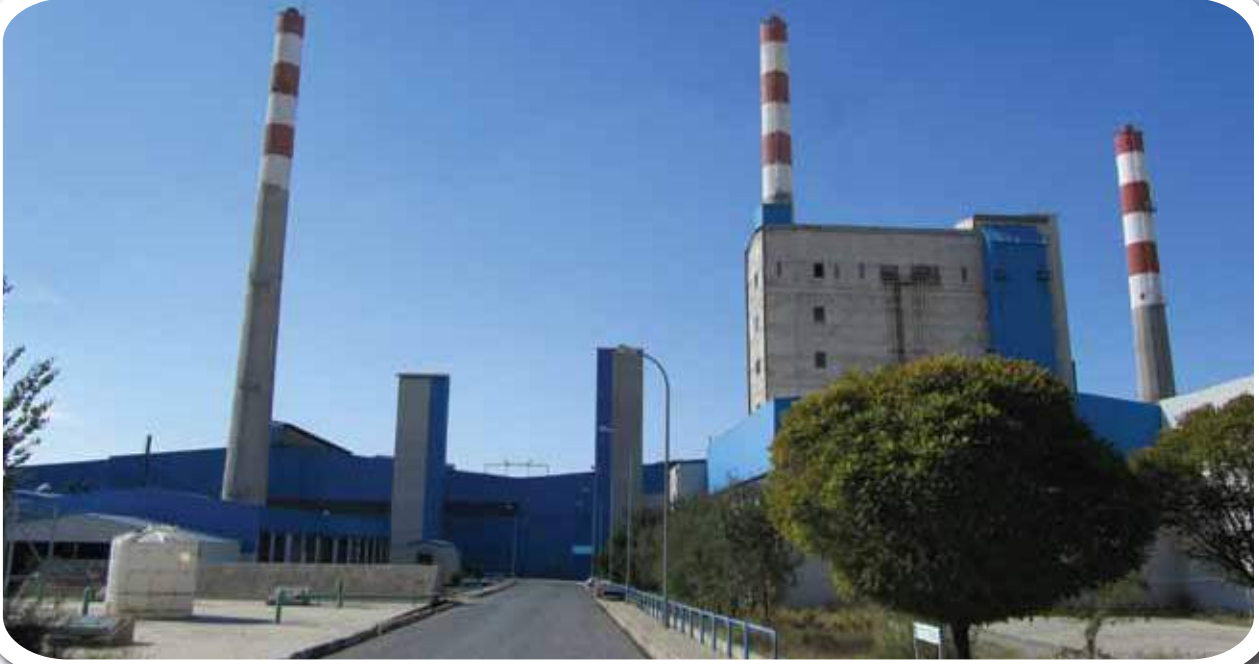
Paşabahçe Eskişehir fabrikası absorpsiyonlu soğutma sistemi elektro-mekanik tesisatı. Absorbtion chiller's systems electro-mechanical installations of Paşabahçe Eskişehir Factory Buildings.
