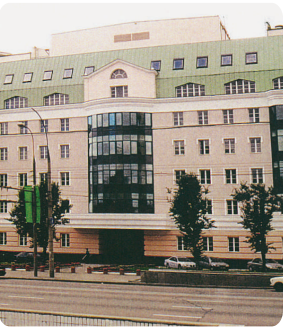
Ziraat Bankası Merkez Ofis, Moskova. Ziraat Bank Head Office Building, Moscow.
