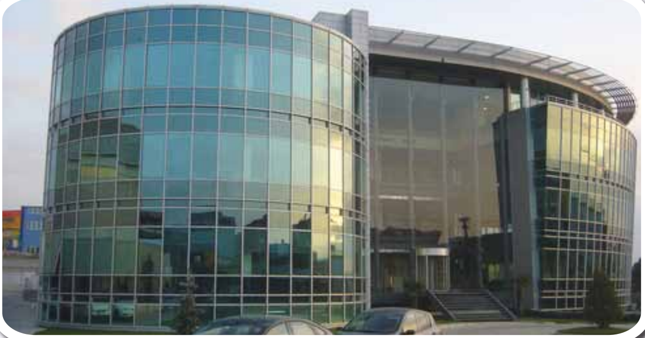
Kayalar Kimya idari bina ofis bölümleri tüm mekanik tesisatı ve bina otomasyonu. Mechanical installations and buildings automation systems of Kayalar Chemistry Head Office Buildings.
