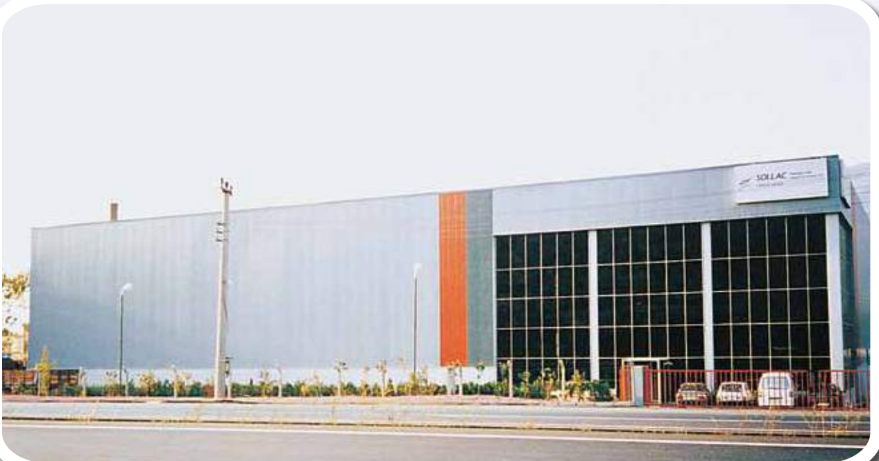
Sollac Gemlik fabrika binası tüm mekanik tesisatı. Mechanical installations of Sollac factory buildings in Gemlik.
