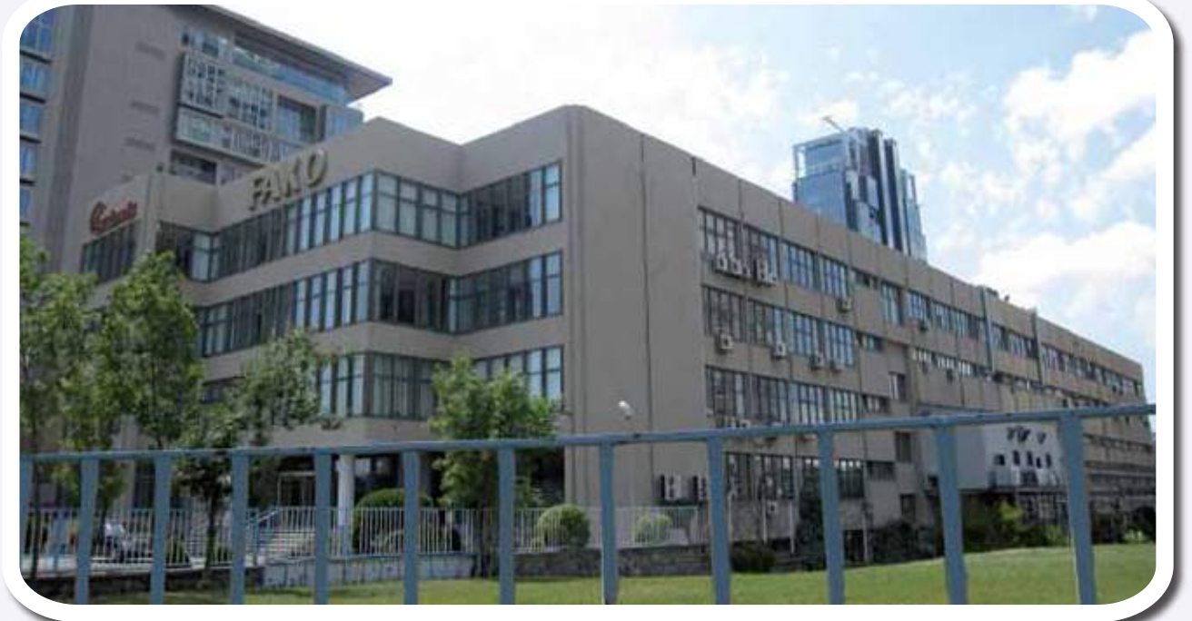
Fako Actavis İlaç Fabrikası yangından korunma tesisatı ilave işleri.
