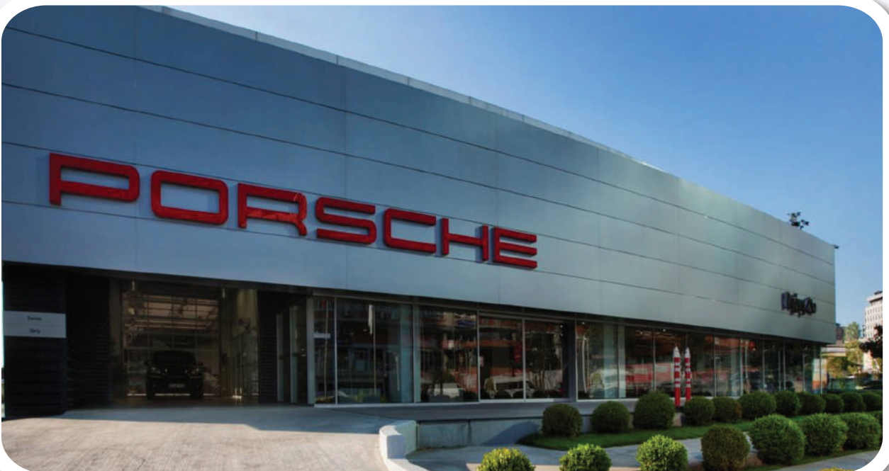
Doğuş Oto Power Center Porsche - VW showroom ve idari bölümlerinin elektromekanik tesisatları, Maslak / İstanbul. Electro-mechanical installations of Doğuş Oto Power Center Porsche VW showroom and services Maslak / İstanbul.
