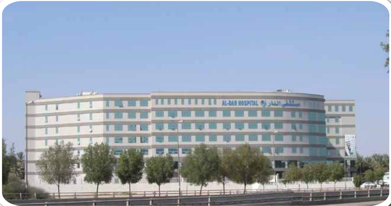
Suudi Arabistan Aldar Hastane binası mekanik tesisat projelerinin, şartnamelerinin ve keşif listelerinin hazırlanması. Project design and BOQ listings of Aldar Hospital Suudi Arabia.
