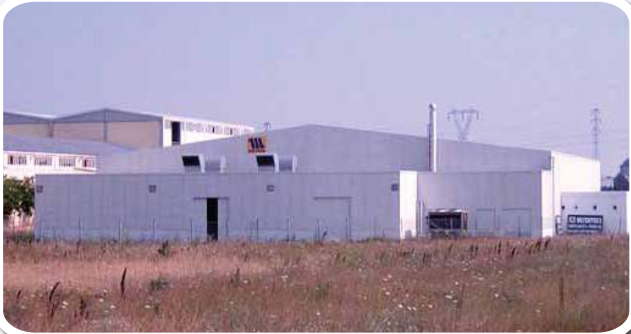
Metem Tekstil Çorlu dokuma fabrika binası tüm mekanik ve otomatik kontrol tesisatı. Mechanical installations and automatic control systems of Metem Textile factory buildings in Çorlu.
