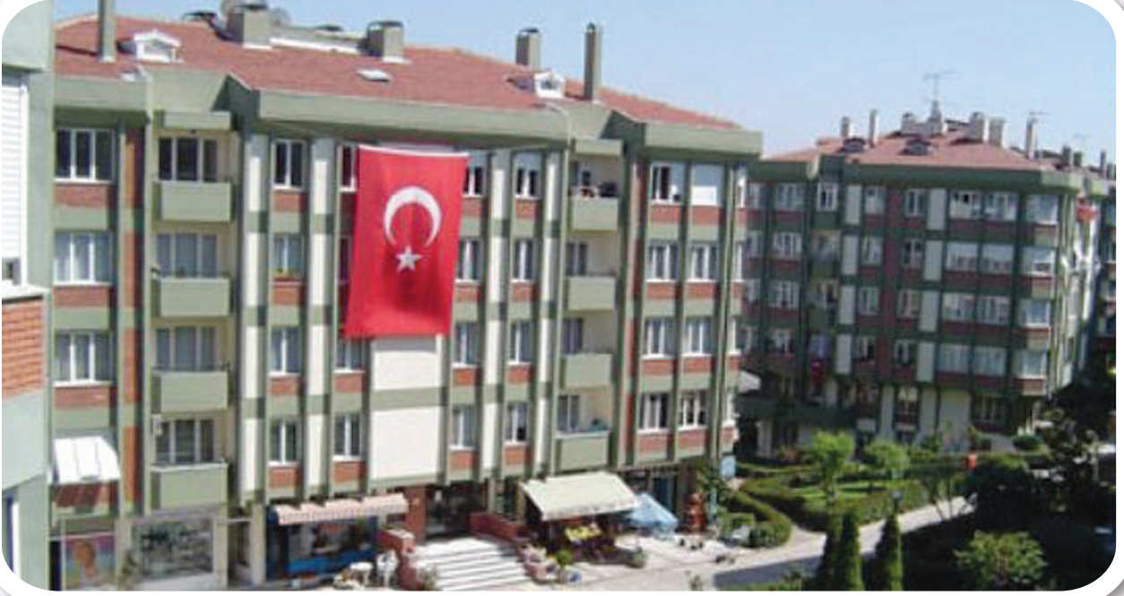
Gazeteciler Sitesi ısı sayacı ölçüm işleri, Maslak / İstanbul. Heat meter (calorimeter) system applications of Gazeteciler Site, Maslak / İstanbul.
