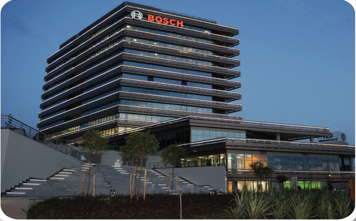
Bosch İstanbul Genel Müdürlük Binası, inşaat, elektrik, mekanik tesisat, otomasyon işleri dahil komple dekorasyon çalışmalarının yapılması. Construction, electrical and mechanical installations, automation systems, complete decoration works of Bosch İstanbul Headquarter.
