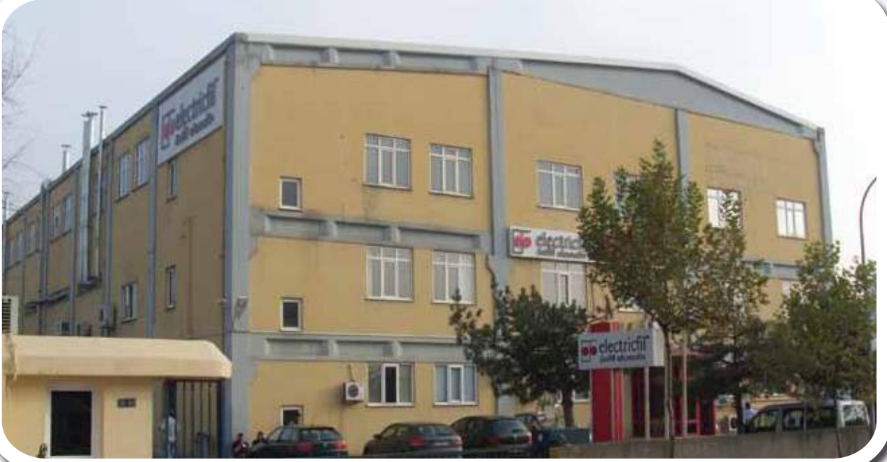
Unifil Electricfil fabrika binası tüm mekanik ve elektrik tesisatı. Mechanical and electrical installations of Unifil Electricfil factory buildings.
