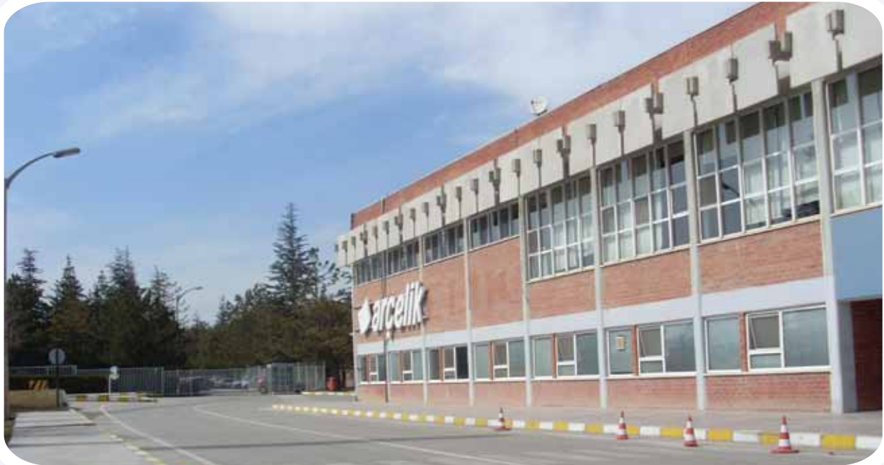
Eskişehir Arçelik fabrika deposu yangın tesisatı. Fire protection installations of Arçelik Eskişehir Factory's Storage Buildings.
