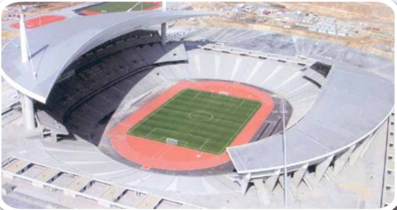
Atatürk Olimpiyat Stadı tüm alt yapı tesisatları. Infrastructure systems of Atatürk Olympic Stadium.
