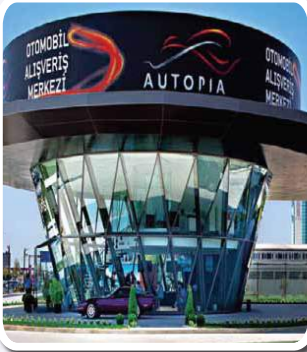
Autopia Otomobil AVM 1. etabı tüm mekanik tesisatı. Mechanical installations of Autopia Auto Shopping Center 1 st. stage.
