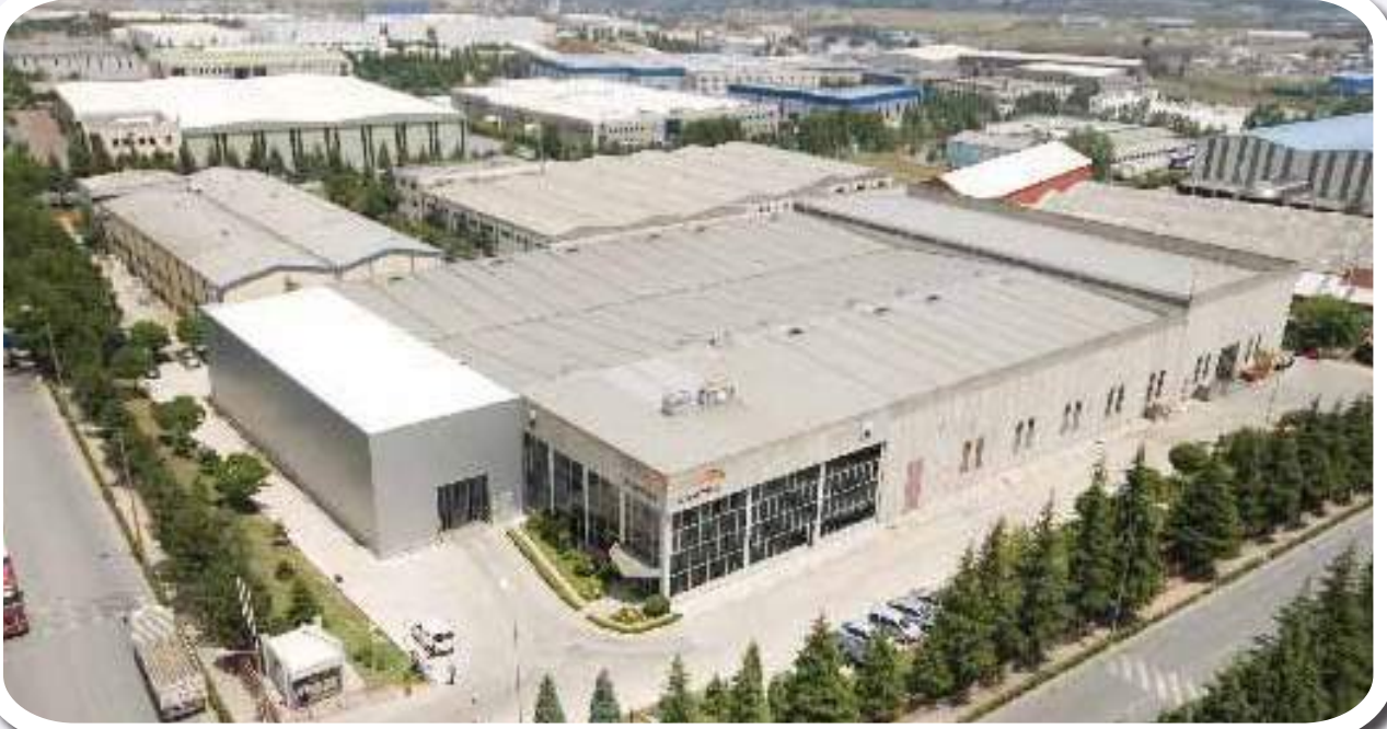
Uginox Gebze fabrika binası tüm mekanik tesisatı. Mechanical installations of Uginox factory buildings in Gebze.
