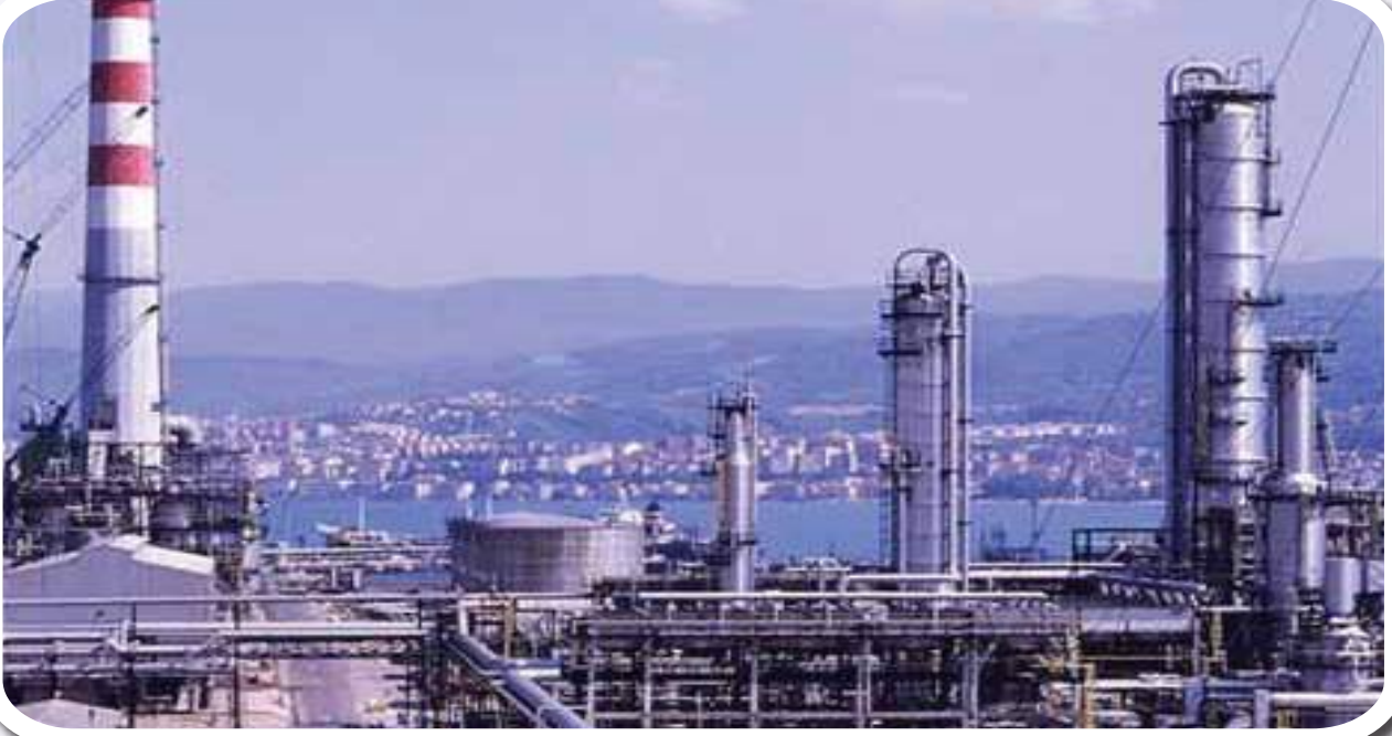
Tüpraş İzmit Rafinerisi, Unicracker ve bağlı ünitelerin tüm mekanik ve otomatik kontrol tesisatı. Mechanical installations and automatic control systems of Tüpraş İzmit Refinery Unicracker and connected units.
