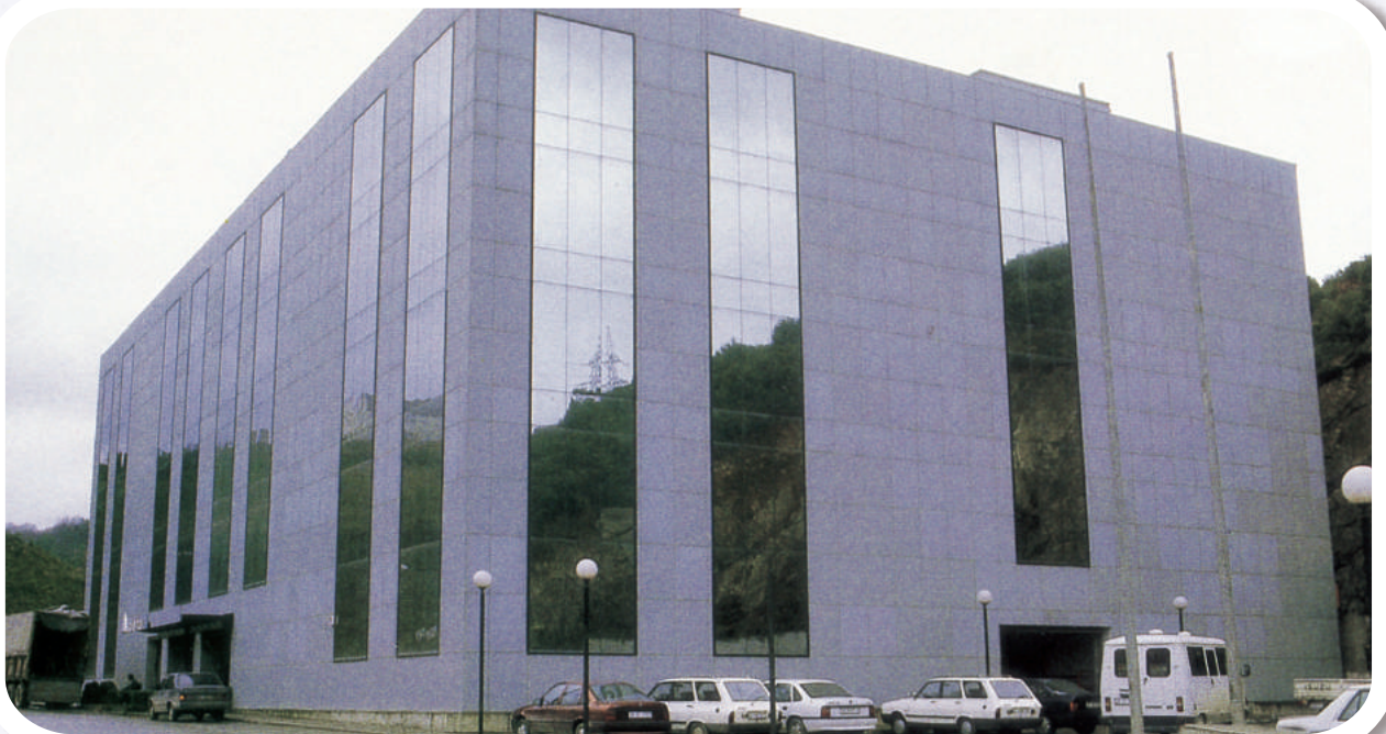
Doğuş Yapı Sanayi A.Ş. Genel Müdürlük Binaları tüm mekanik ve otomatik kontrol tesisatı. Mechanical installations and automatic control systems of Doğuş Yapı Sanayi A.Ş. Head Office Buildings.
