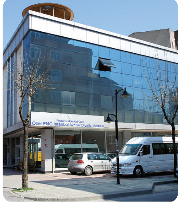
Avcılar Diyaliz Merkezi tüm mekanik tesisatı. Mechanical installations of Avcılar Dialysis Center.
