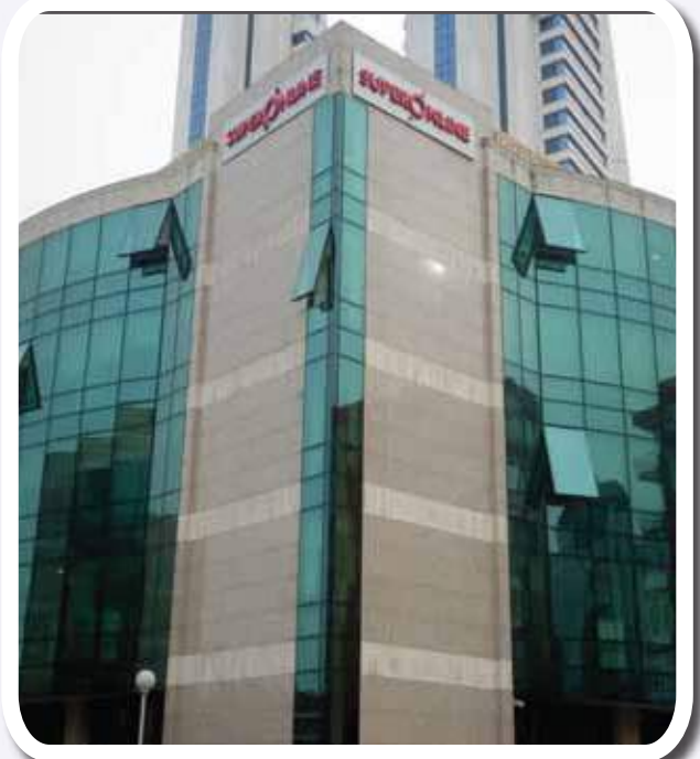
Superonline Genel Müdürlük binası tüm mekanik tesisatı. Mechanical installations of Superonline Head Office.
