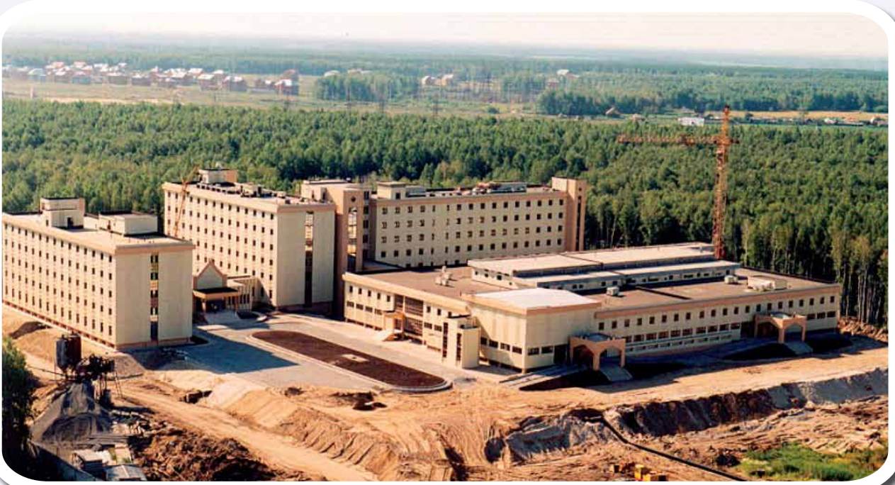
Rusya Tyumen Tıp Merkezi tüm mekanik tesisatı. Mechanical installations of Tyumen Medical Center in Russia.
